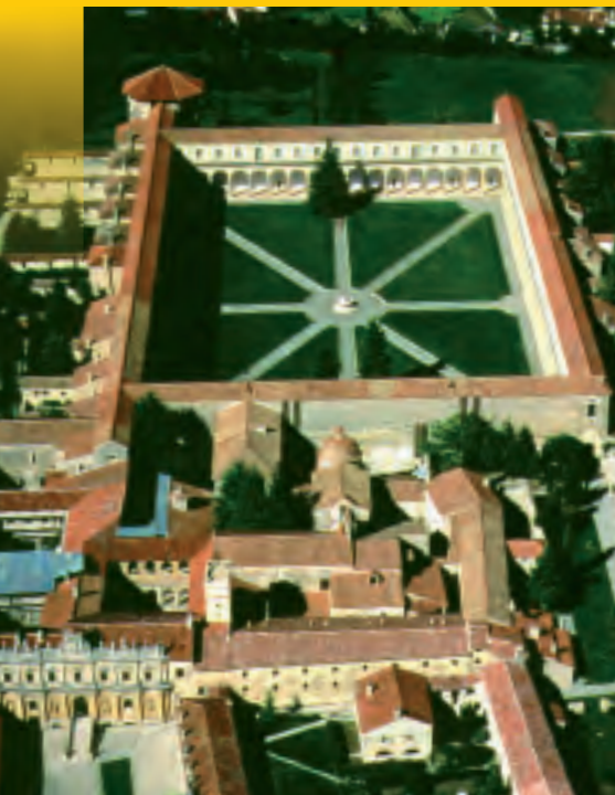
Veduta aerea della Certosa di Padula e vari esterni del complesso.
